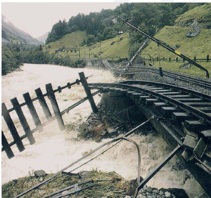
◀ Unterbrochene Bahnlinie am Gotthard: Im August 1987 wurde die Gotthardstrecke durch massive Unwetter für Wochen unterbrochen
